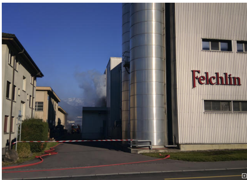
Die Zufahrt zum Areal wurde abgesperrt. | Geri Holdener, Bote der Urschweiz
